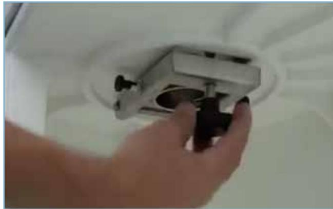
Enclancher les deux vis de verrouillage et resserrer la poignée du cadre de verrouillage.
